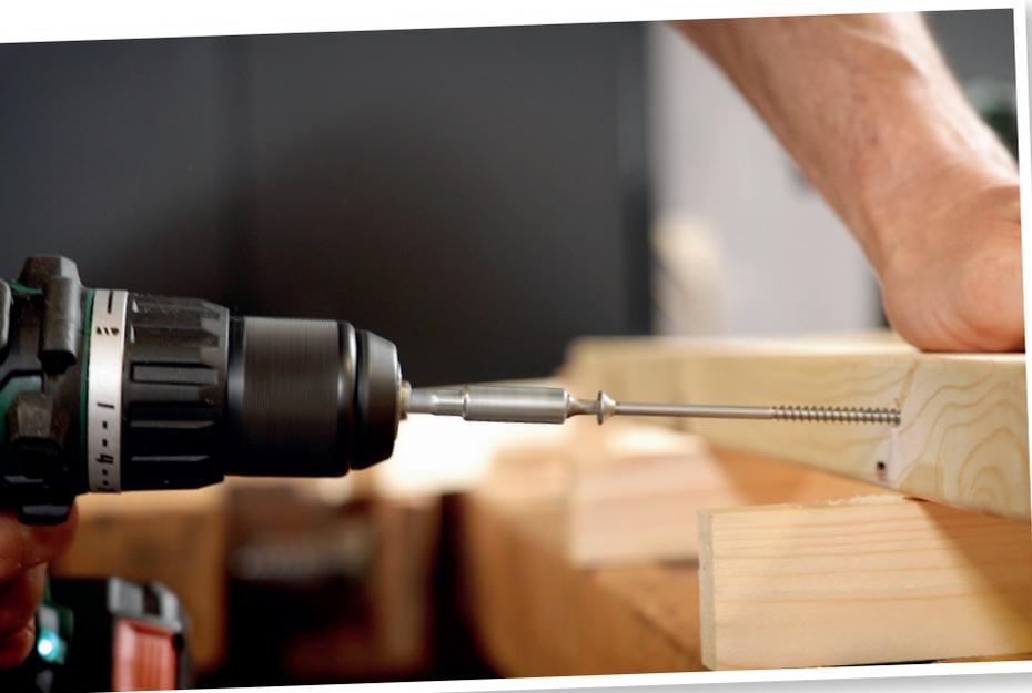
Vous vissez les lattes coupées droites avec des vis à tête fraisée 5 x 100 mm en acier inoxydable. Le renfort transversal que vous avez scié en onglet, est vissé avec des vis de 5 x 8 mm.
