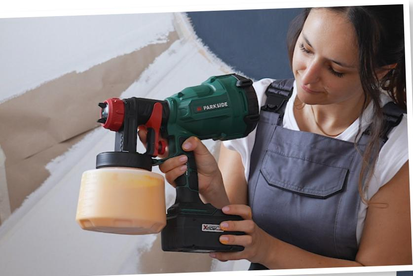
A continuación, vierte la mezcla en el depósito de pintura de la pistola de pulverización y establece la dirección de pulverización con la que deseas comenzar.
